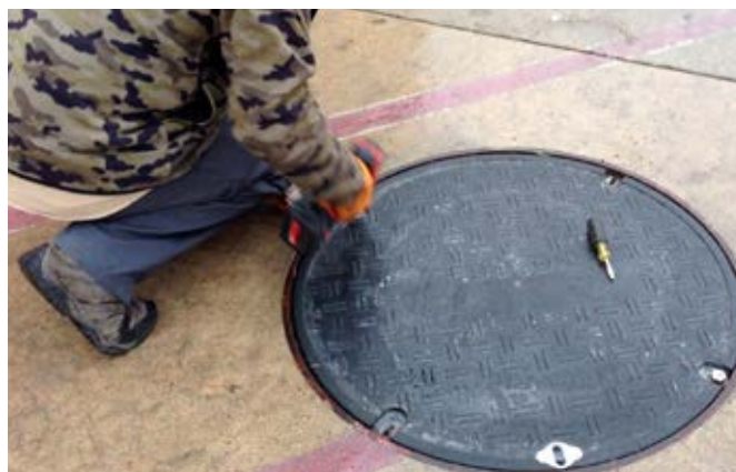
Les couvercles de regard en composite non conducteur sont un choix sûr pour les services d'électricité et les municipalités, car ils offrent une protection isolante aux travailleurs et aux piétons.
