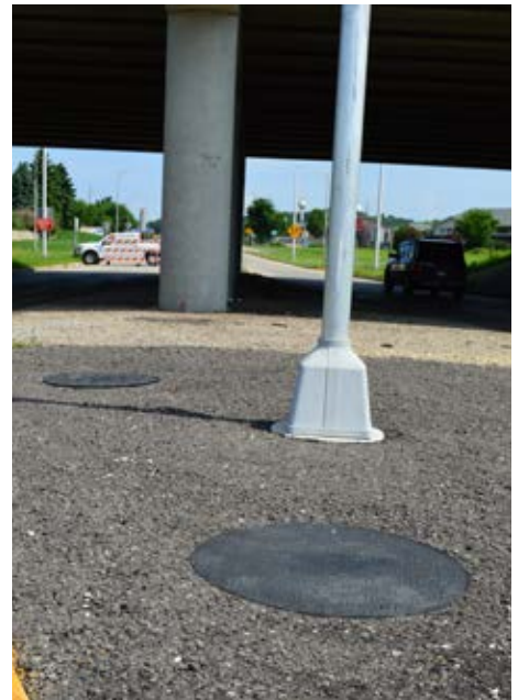
Des Trou de main DUROCOM installées.
