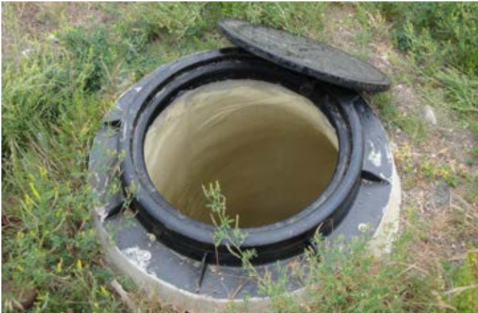
Les cadres et couvercles en composite non-corrosifs sont très bien adaptés aux endroits où des concentrations de sulfure d'hydrogène ou d'autres gaz corrosifs sont élevés.
