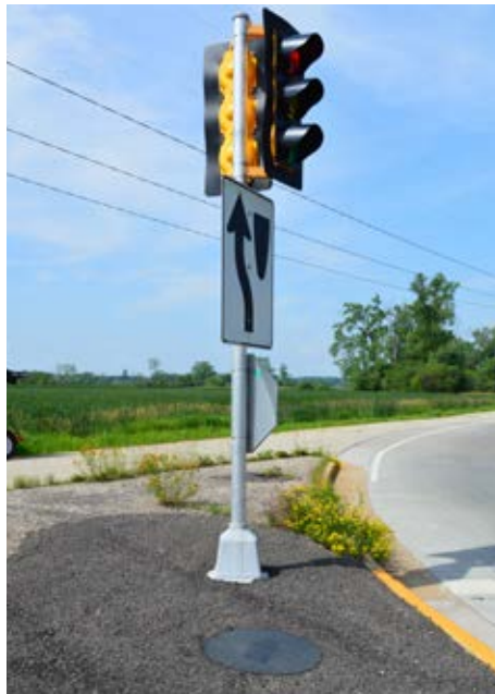
Trou de main DUROCOM installé près des feux de circulation.
