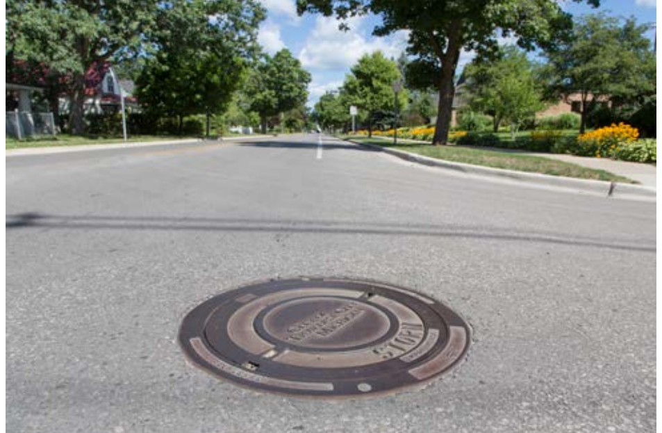
Ensemble SELFLEVEL installé à Traverse City, Michigan.
